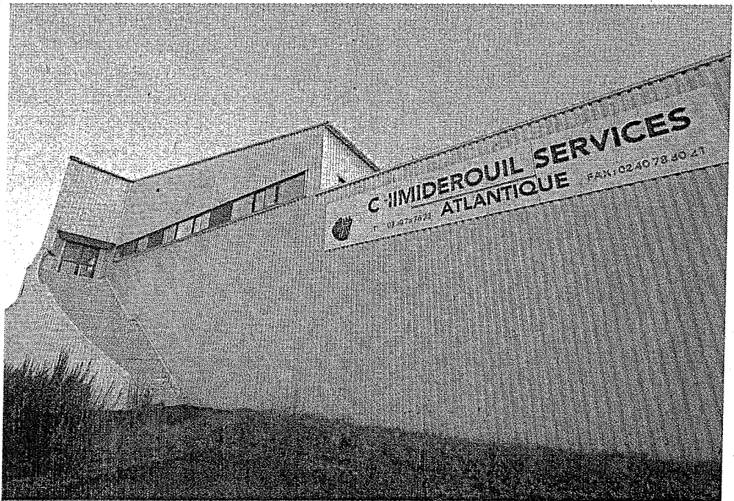
Chimiderouil a fait faillite il y a trois ans. Trois cents mètres cubes d'acide viennent tout juste d'en être évacués.
